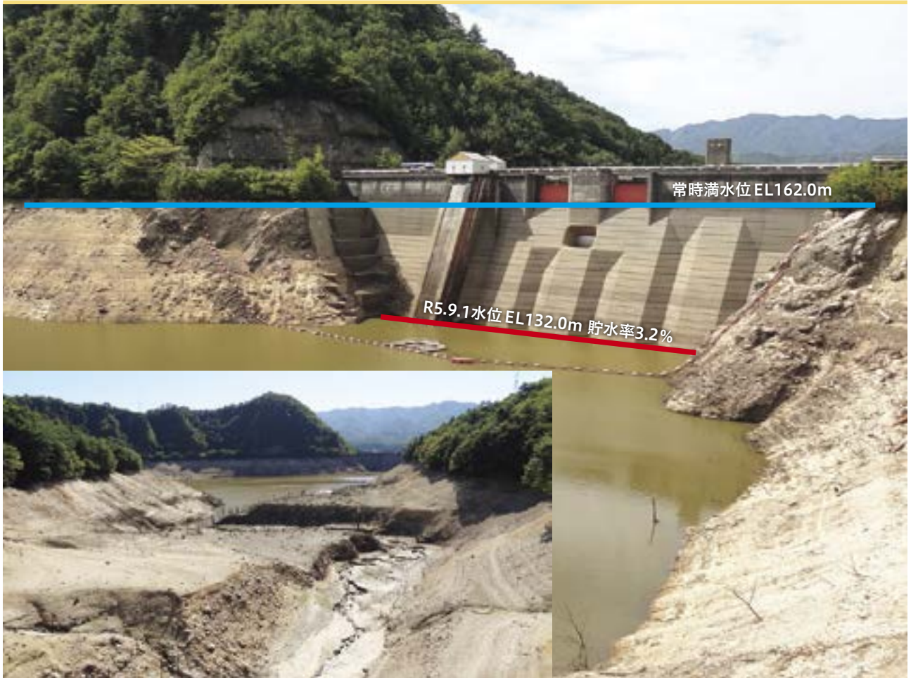
令和5年9月1日 内の倉ダム枯渇状況
