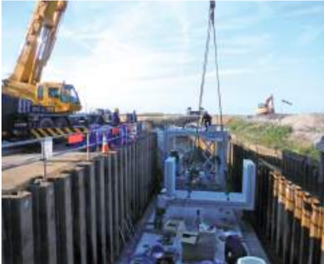
ボックス断面施工中
