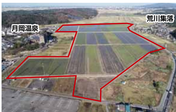
荒川川左岸側耕地 竣工
