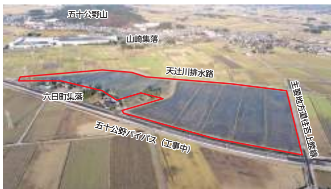
第28次工事 全景
