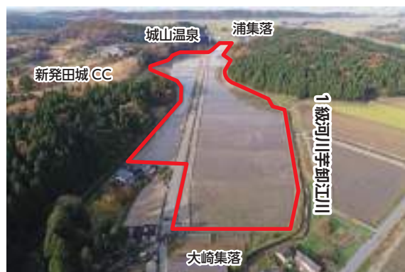
第26次工事 全景
