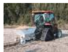
籾殻充填補助暗渠の様子
