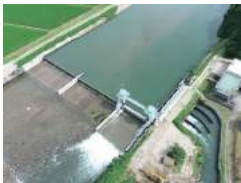
加治川第1頭首工
