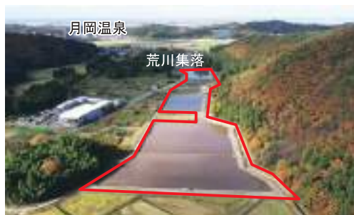
区画整理第11次工事の様子（令和4年11月）
