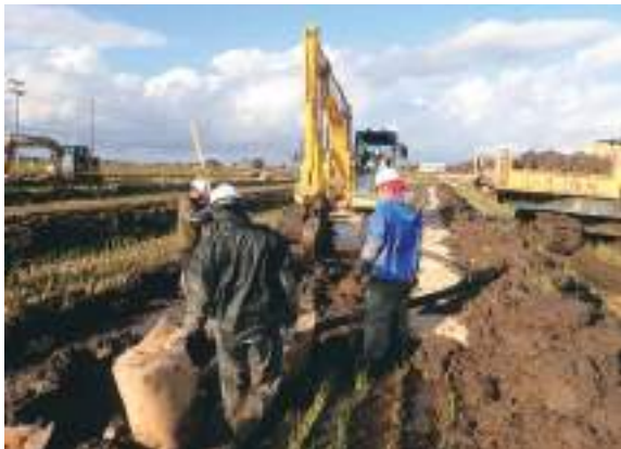
暗渠排水工事の様子
