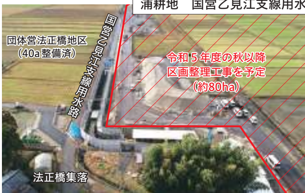
国営乙見江支線用水路 水路工事の様子
