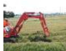
バックホーによる 周囲明渠の様子
